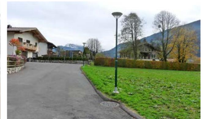
Fertigstellung Erschließung Taxachgründe - Oberflächenein Kanal, Schächte, Asphaltierung, Beleuchtung
